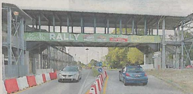
Il nuovo ponte del centro commerciale sarà punto di arrivo e partenza del 55° Rally Fvg (FOTO PETRUSSI)
