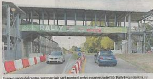
Il nuovo ponte del centro commerciale sarà punto di arrivo e partenza del 55° Rally Fvg per il 30 e 31 agosto
