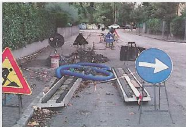
Un cantiere per la posa della fibra ottica in via Felpo.
