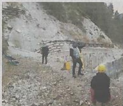
SOPRALUOGO Si costruirà un ponte tibetano lungo circa 54 metri
